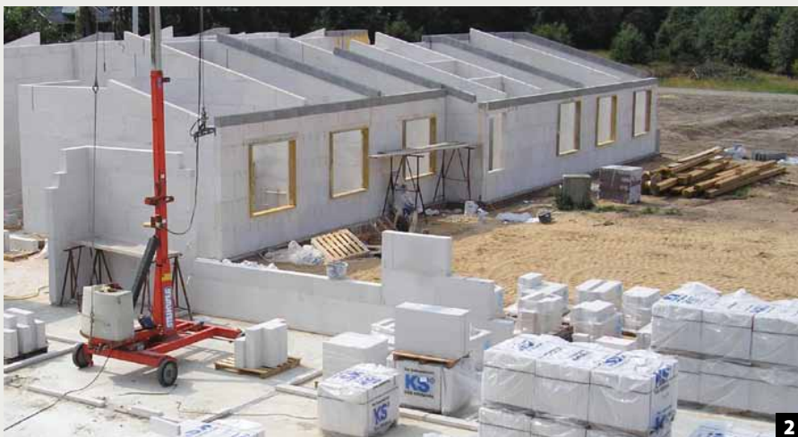
2 Verarbeitung mit einem Versetzgerät mit bis zu 0,65 m 2 Mauerwerk in einem Hub
