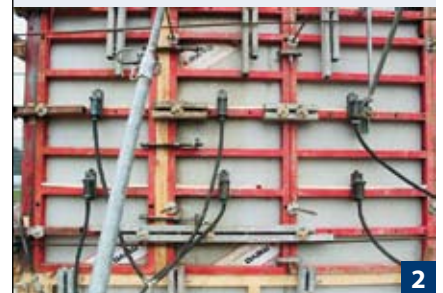
2 Ist der Außenrüttler die ideale oder einzig mögliche Verdichtungsmethode, dann gilt: Paarweise, Betonlage für Betonlage und von unten nach oben rütteln. Immer nur ein Rüttlerpaar einschalten, nicht mehrere gleichzeitig.
