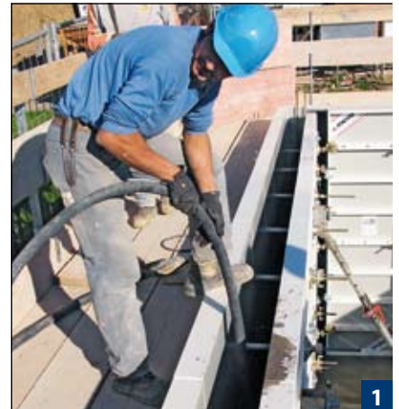
1 Beim Innenrütteln wird die Rüttelflasche möglichst senkrecht in den Beton eingelassen.
