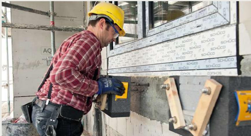
Mit dem Wärmedämmelement Isokorb Typ RKS konnten die frei ausragenden Balkone an das Bestandsgebäude montiert werden.
