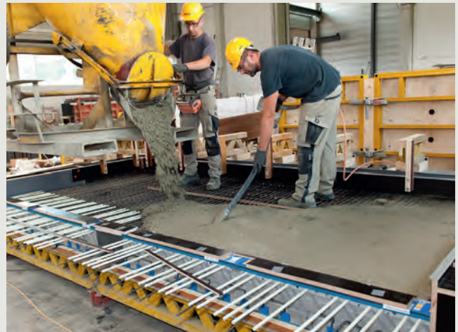
Mit dem Isokorb XT-Combar ist eine geringere Betondeckung als bisher notwendig. Somit kann die Bewehrung zuerst fertiggestellt und anschließend der Isokorb eingesetzt werden.
