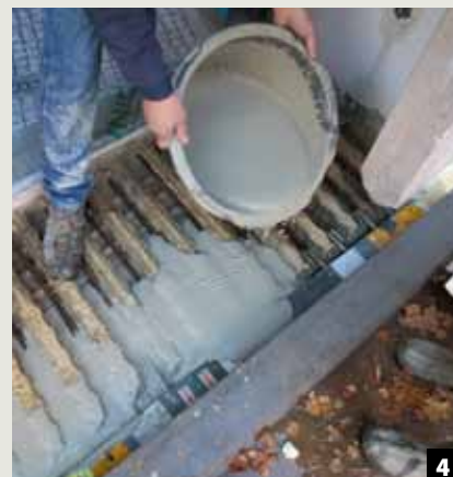
4 Die Aussparungen in der Decke werden nachträglich mit einem Vergussbeton verfüllt. Die Montage der Stahlbeton-Balkonplatten kann mit der Schöck Isokorb® ID während der Rohbauphase zu einem späteren Zeitpunkt als die Betonage der Decke erfolgen.
