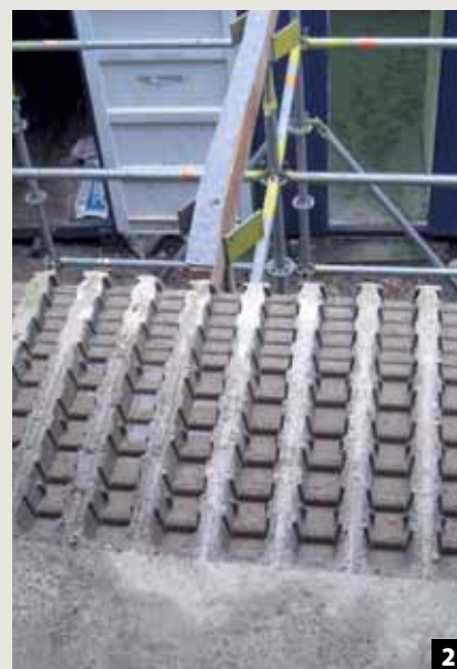
2 Decke nach Entfernung des Schöck IDock Aussparungselements.
