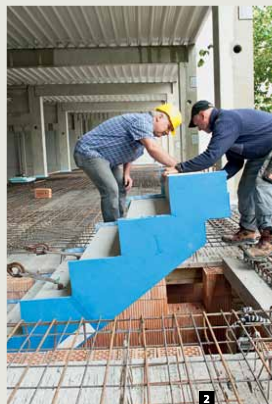
2 Einsetzen der trittschalldämmten Treppe
