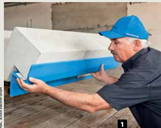
1 Einbau der Schöck-Tronsole® Typ F
