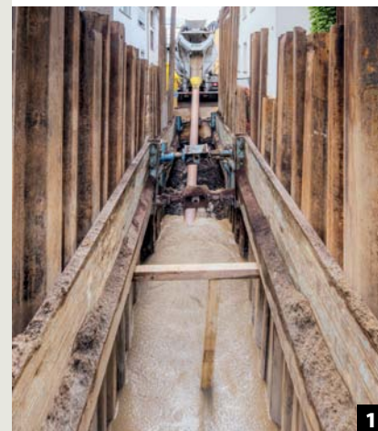
1 Ein typisches Einsatzgebiet: die Verfüllung von Gräben
