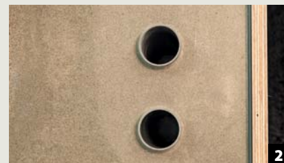
2 Optimale Verdichtung auch um Leitungspakete oder Rohre
