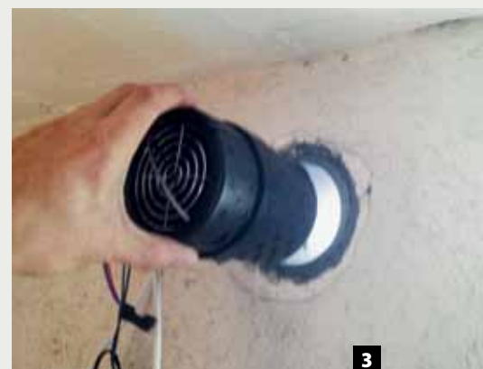
3 Lüftermodul einsetzen
