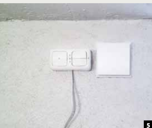
5 Ansicht nach Montage innen
