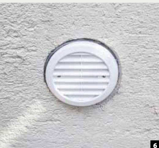
6 Ansicht nach Montage außen
