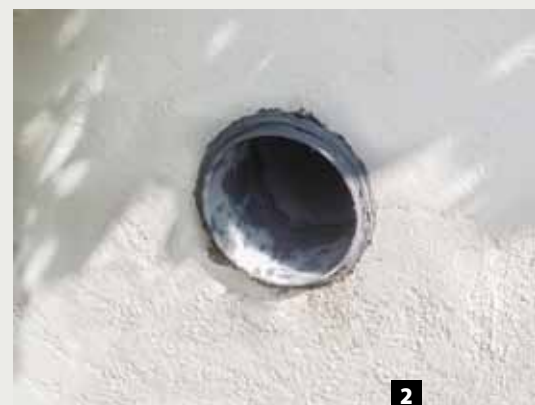
2 KG2000 Rohr auf gewünschte Länge (incl. ev. Putzdicken) kürzen und abdichten
