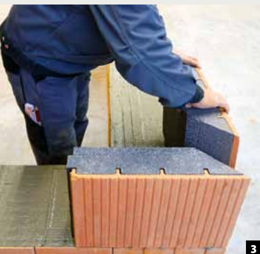
3 Die Deckenrandschale in das frische Mörtelbett setzen.
