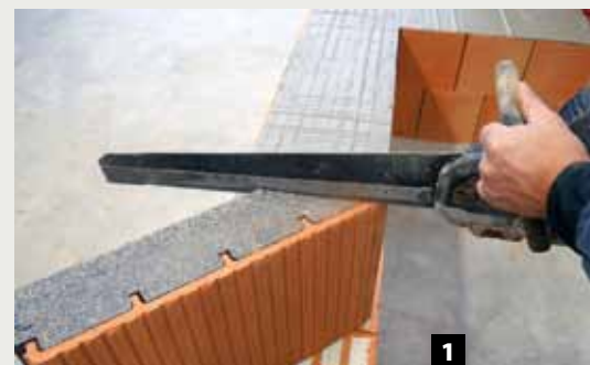
1 Die Deckenrandschale auf Gehrung schneiden
