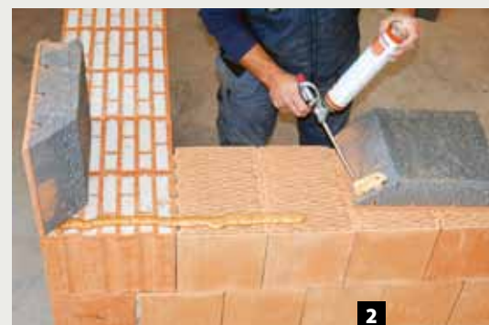
2 Zur Stabilisierung des Eckbereichs die Schnittfläche mit Poroton-Dryfix-Kleber oder schwach expandierendem PU-Schaum verkleben
