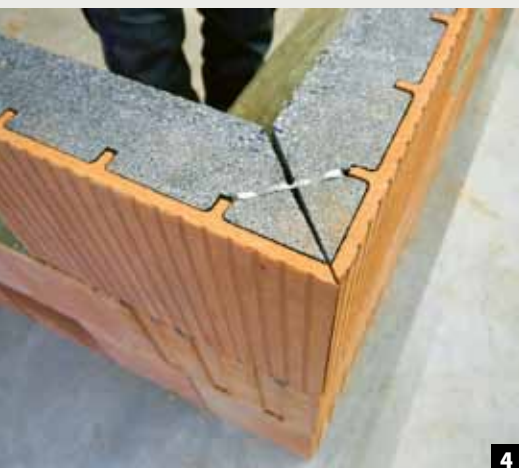
4 Die Ecke mit dem DRS-Eckwinkel stabilisieren.
