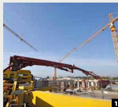
1 Typischer Einsatz einer Betonpumpe
