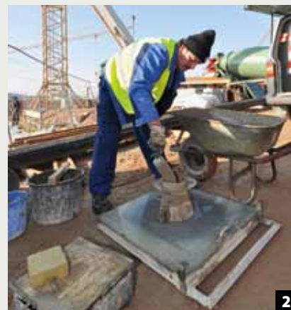
2 Konsistenzprüfung vor dem Pumpen
