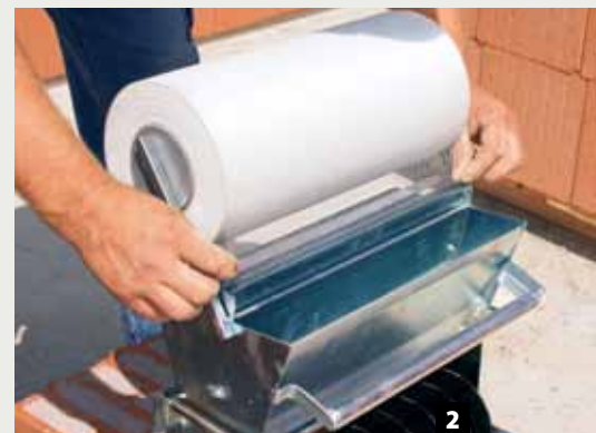
2 Einlegen des Gewebes in die V.Plus-Walze
