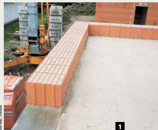
1 Anlegen der ersten Lage auf einer Ausgleichsschicht aus geeignetem Mauermörtel; lot- und waagrecht
