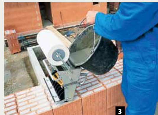
3 Befüllen der Walze mit Dünnbettmörtel
