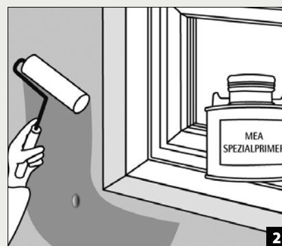
2 Auftragen des Spezialprimers
