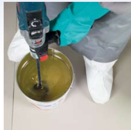
Für die Verarbeitung von Chemikalien im Betrieb erhält der Bauunternehmer zukünftig neue Sicherheitsdatenblätter im REACH-Format.
