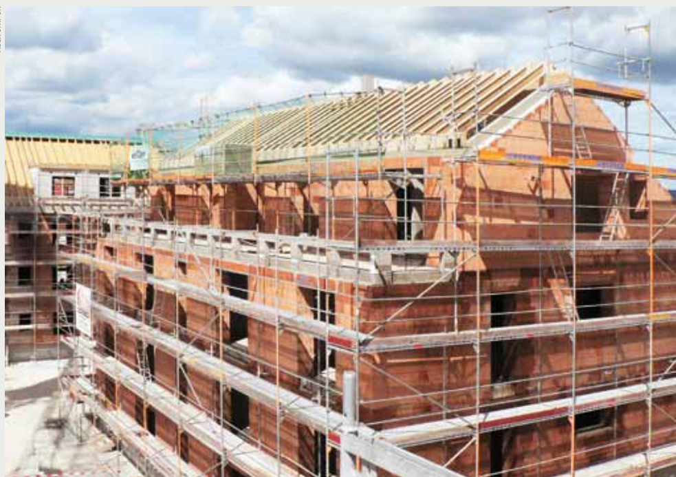
Der kontrollierte Rückbau von Gebäuden mit gefüllten Mauerziegeln ist derzeit noch die Ausnahme. Anfallende Baustellenabfälle können problemlos wie üblicher Bauschutt auf DK-0- oder DK-1-Deponien gelagert werden.
