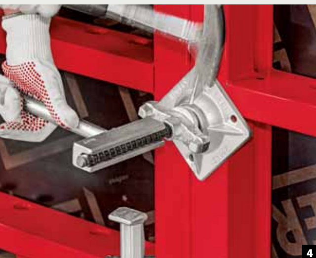
4 Der Spannstabschlüssel verhindert das Mitdrehen des DW-15-Ankers beim Ein- und Ausschalen – ohne zusätzlichen Mann auf der Gegenseite.
