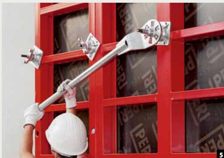
5 Der Ankerschlüssel dient dem einfachen Anziehen und Lösen von Flügelmuttern und Muttergelenkplatten ganz ohne Hammer.
