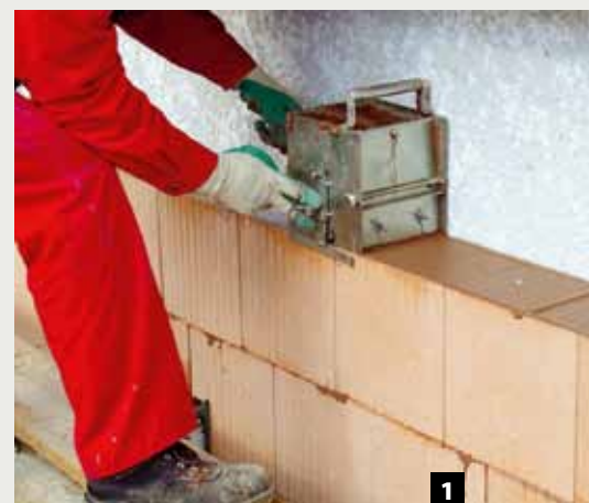
1 Die Wärmedämmfassade wird entweder auf einem Betonfundament oder Edelstahlkonsolen, bei einer Innendämmung auf Bodenplatte bzw. Geschossdecke, der Bestandswand entlang hochgemauert. Der Auftrag des Dünnbettmörtels auf den Lagerfugen erfolgt mit dem Mörtelschlitten.
